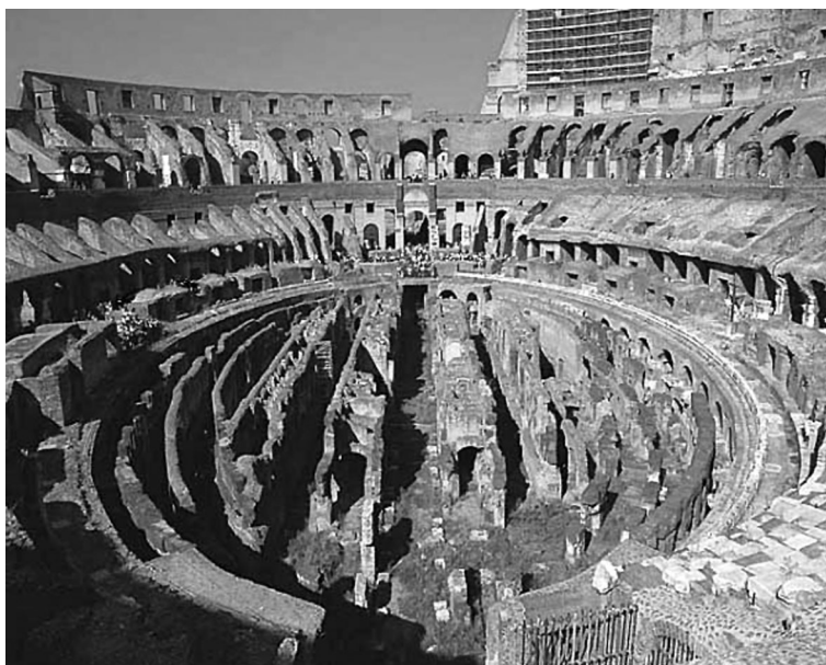
Das Kolosseum in Rom wurde um 80 n. Chr. fertiggestellt. Über dem elliptischen Grundriss erhoben sich 4 Stockwerke. Bis zu 70'000 Zuschauer konnten von den Sitzreihen aus den Gladiatoren- und Tierkämpfen beiwohnen. Unter der Arena befanden sich Käfige für die wilden Tiere, Galerien, Lager-, Umkleide- und Kellerräume.
